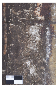
Wasserschaden der Fassung im unteren Bereich der Rücklage
