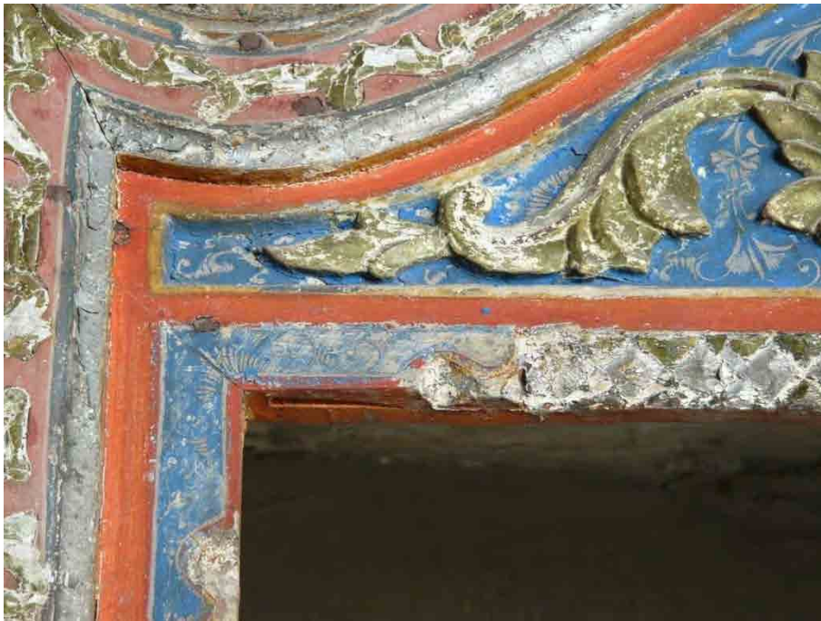
Abb. 399: Bait al-Ḥawrānīya, Kat.-Nr. XXI 2-961, Raum östlich des īwān im inneren Hof, datiert 1204 H / 1789-90 AD, Detail des rechten Wandregalnischenrahmens, Westwand tazar
