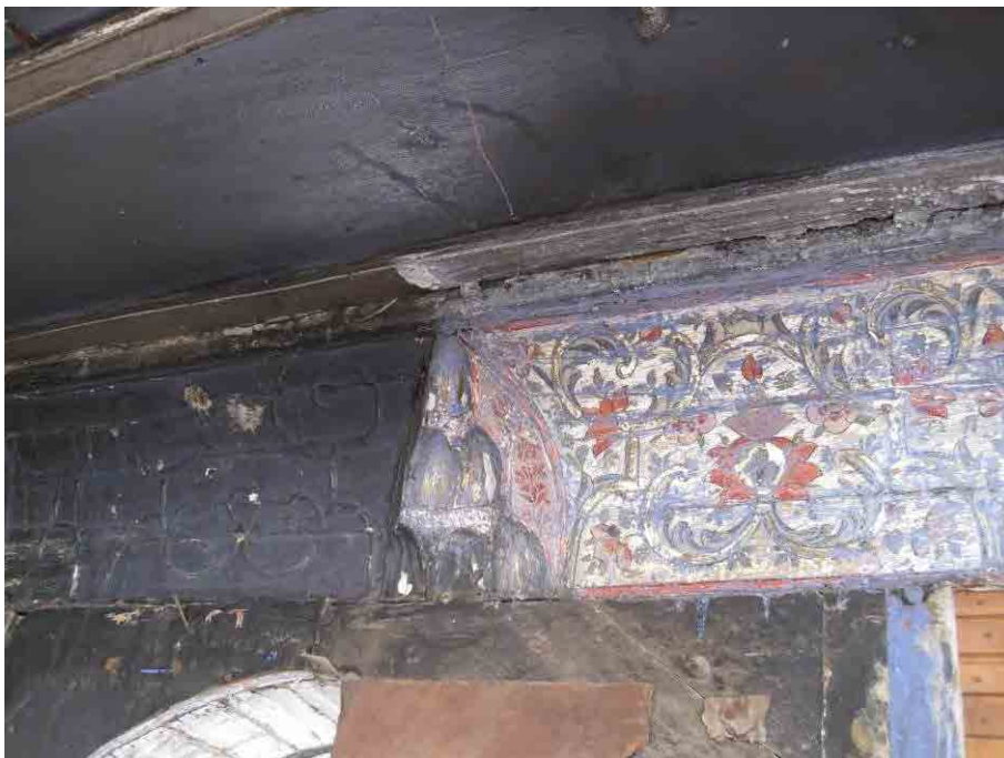
Abb. 593: Bait Salīm al-Quwatlī, Kat. Nr. XVIII-408, Korridor im OG des Ostflügels: Gesims und Decke sind mit dunkelblauem monochromem Anstrich renoviert, der die ursprüngliche detailreiche Polychromie verdeckt, Freilegungsprobe durchgeführt von Shadi Khalil, April 2010
