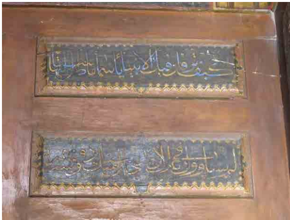
Abb. 575, Abb. 576: Qaṣr As‘ad Bāšā al-‘Aẓm, Damaskus, „Bride’s Hall“, Schrifttafeln an der ‘ataba-Nordwand oberhalb des Fruchtschalenpaneels: Unter den abgeplatzten Buchstaben ist der ursprüngliche, leuchtend blaue Farbton der Smalte erkennbar. Durch den Firnisaufrag ist der originale blaue Hintergrund der Schriftkartusche verschwärzt.
