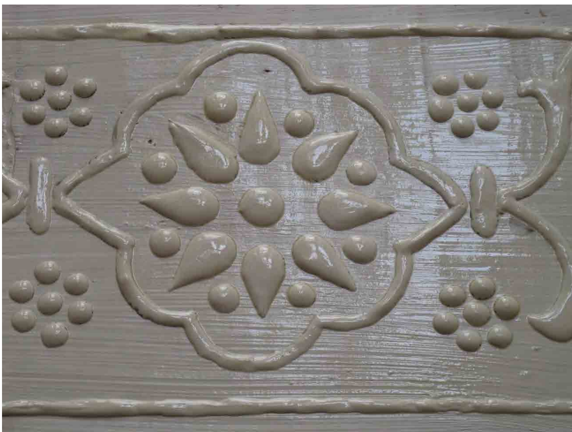
Abb. 454: 5. Arbeitsschritt: Aufstreichen des Anlegeöl für die Zinnfolie – 3h-Öl Fa. Lefranc
