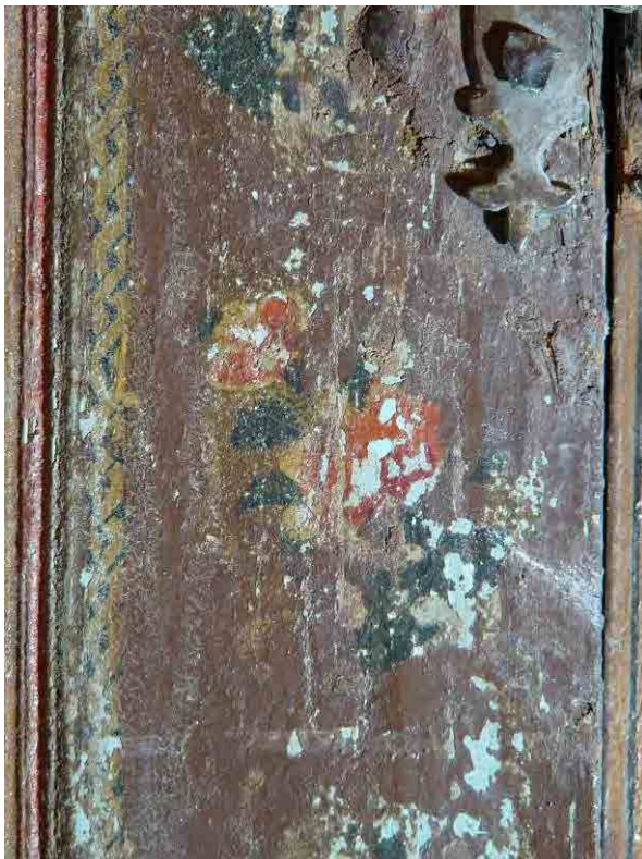
Abb. 589, Abb. 590: Bait as-Sibā'ī, Kat.-Nr. XIII-227, qā'a im Nordflügel des Haupthofes, nördlicher ṭazar , Wandschrantür an der Ostwand; spannungsreiche, verbräunte Harzüberzüge führen zu Abplatzungen der Malschicht, die rot gemalten Streublümchen auf dem hellblauen Rahmen sind bereits stark beschädigt
