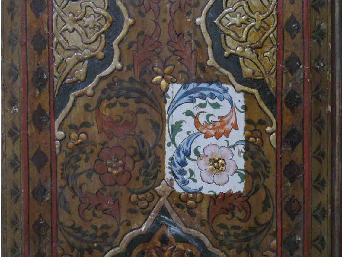
Abb. 571: Bait as-Sibā'ī, Kat.-Nr. XIII-227, qā'a im Westflügel des südlichen Hofes, datiert 1183 H / 1769-70 AD, Wandpaneel an der ṭazar -Westwand, Test zur Abnahme vergilbter Firnissschichten, durchgeführt von Shadi Khalil, Januar 2012
