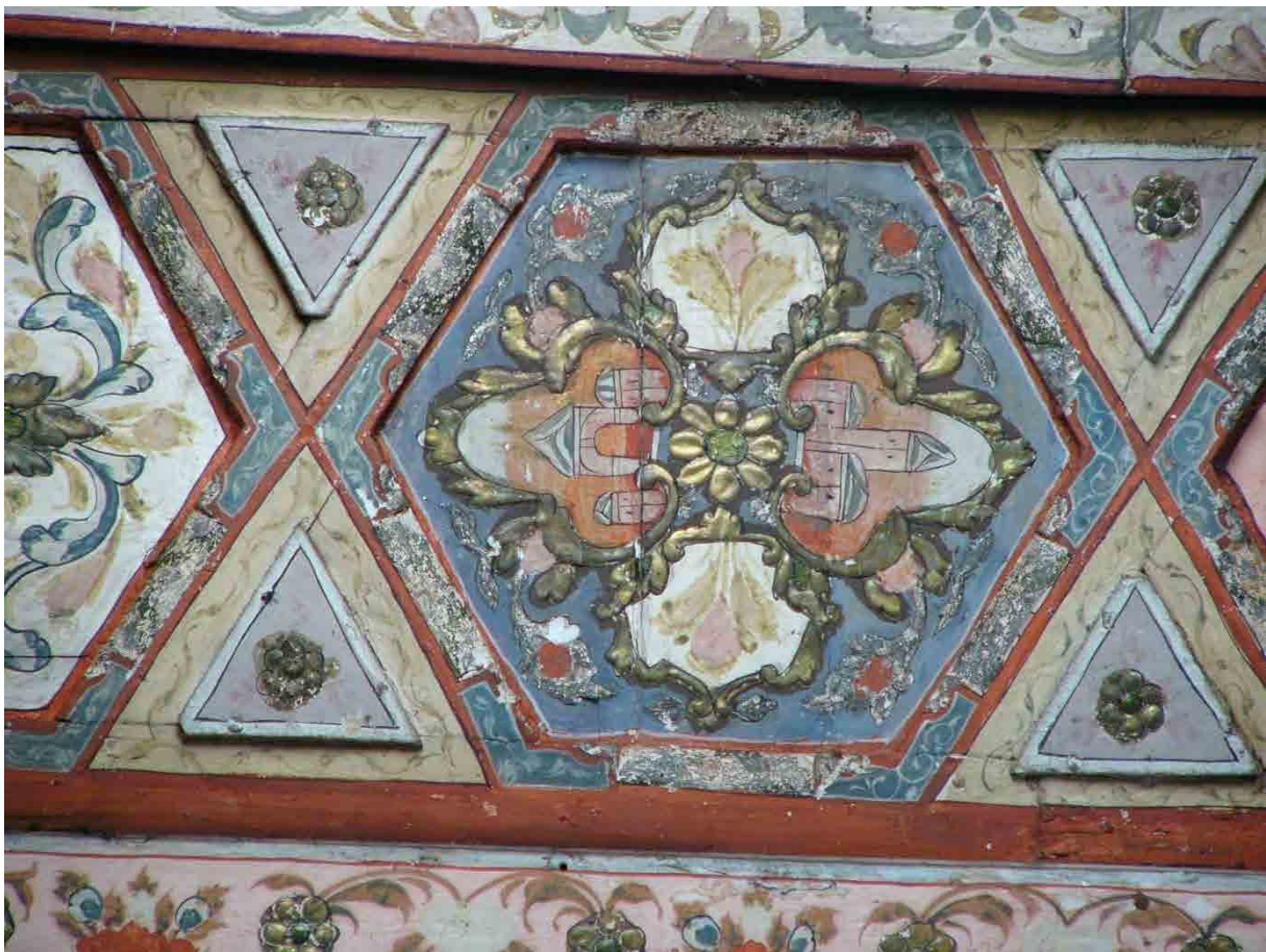
Abb. 618: Detail des äußeren Rahmens der 'ataba-Decke
