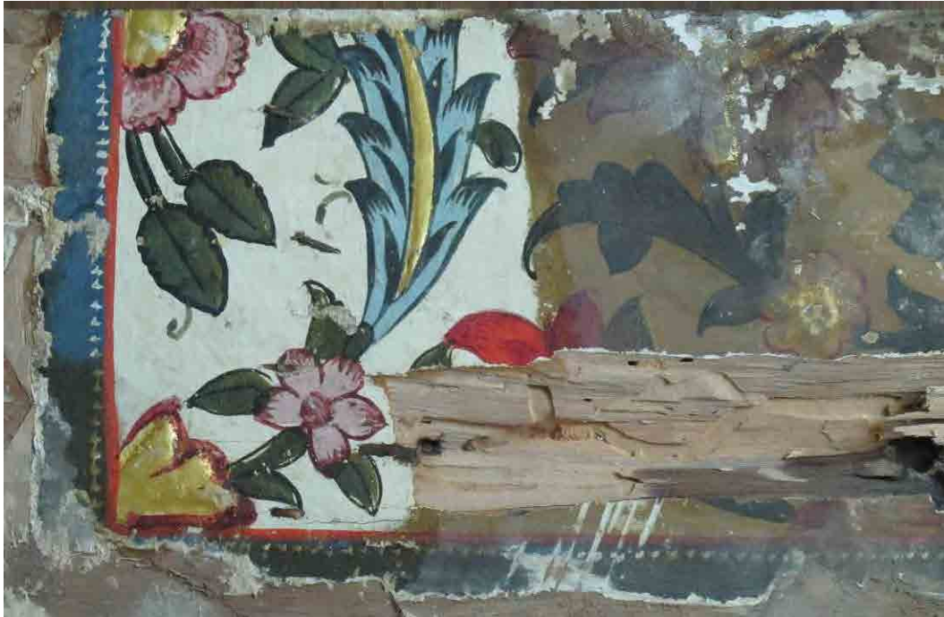
Abb. 580: Wiederverwendetes Brett aus dem Bait Ḥasan al-Quwatlī, Damaskus, mit Aceton konnte der vergilbte Überzug entfernt werden, die originale Farbigkeit kam in beeindruckender Brillanz wieder zum Vorschein.
