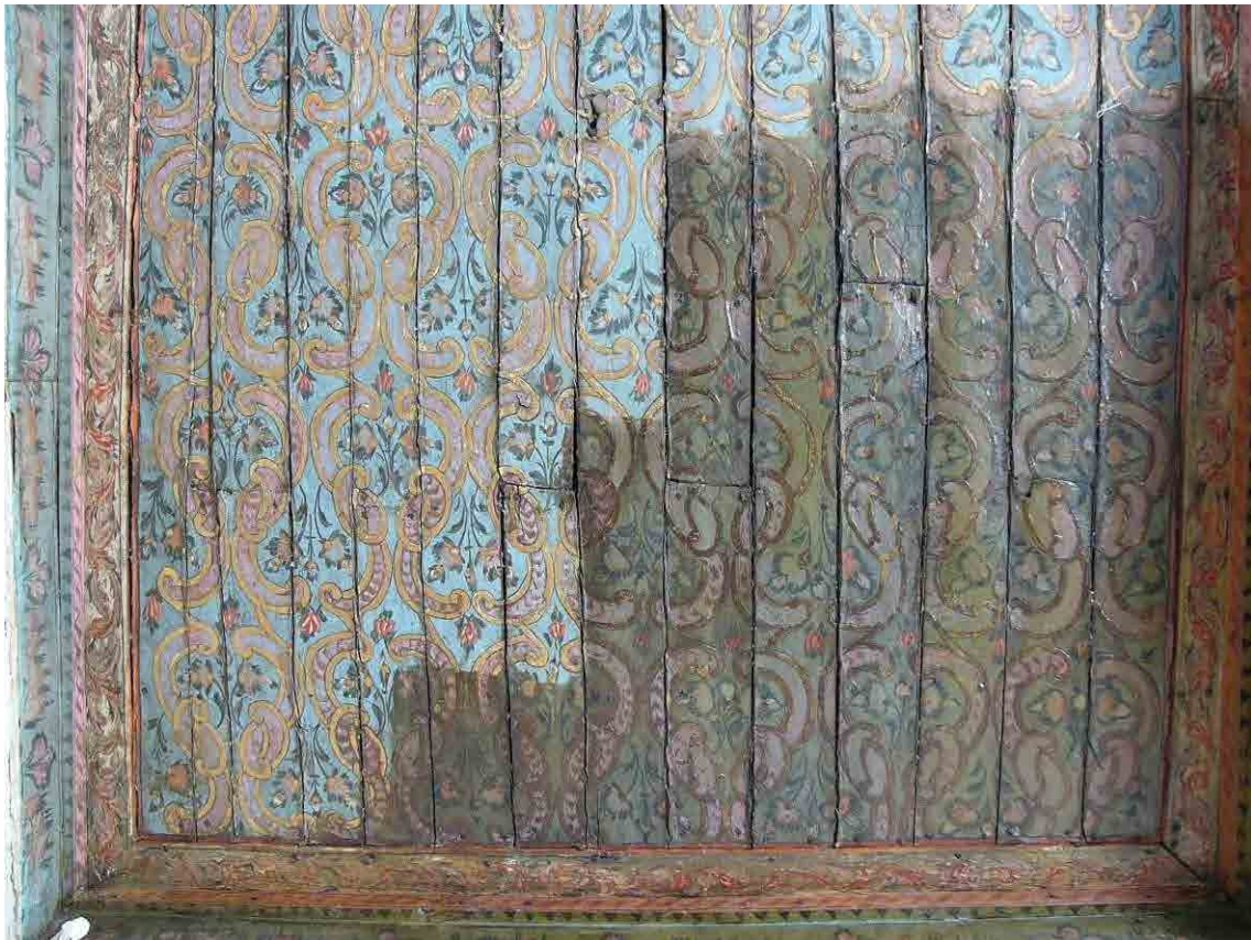
Abb. 570: Bait an-Nawfara, Damaskus, Raum im Ostflügel 1. OG, während der Firnisabnahme, ausgeführt von Shadi Khalil 2009
