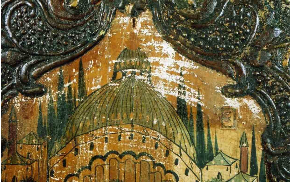
Abb. 588: Arabicum, Villa Gutmann, Potsdam, Wandpaneel in der linken Hälfte der Eingangswand, durch hohe Eigenspannung der Firnisüberzüge abplatzende Farbschichten
