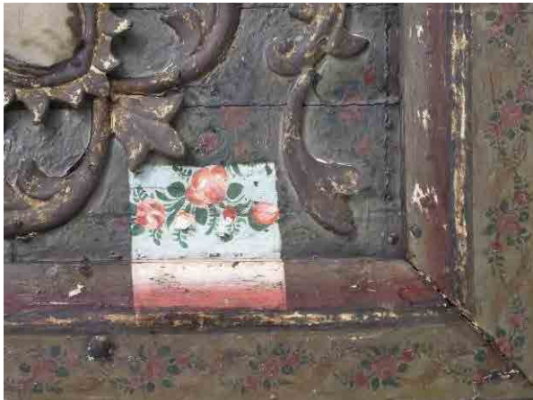
Abb. 611, Abb. 612: Bait Salīm al-Quwatlī, Kat. Nr. XVIII-408, Raum im EG des Ostflügels, Proben zur Abnahme der Rußbeläge, ausgeführt von Shadi Khalil, März 2010
