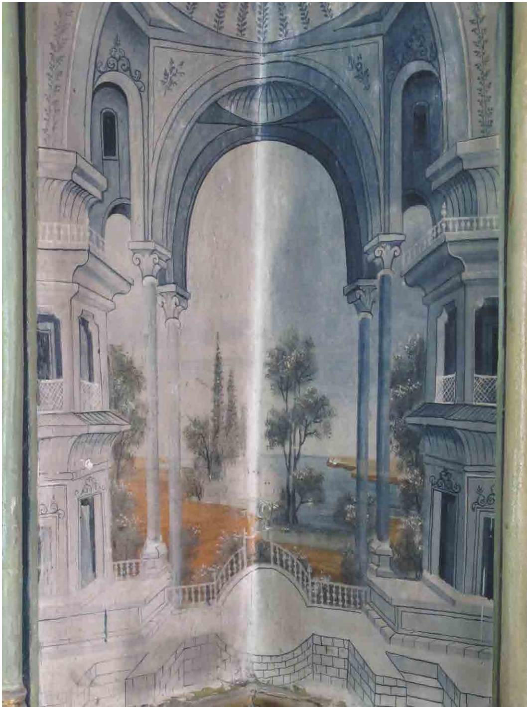
Abb. 547: Bait Nizām, Kat.-Nr. XIII-334, Weintraubenzimmer, 'ataba, Wandmalerei in der Südwestecke der oberen Wandzone; die Malerei auf der Südwand, welche das Licht von dem gegenüberliegenden Fenster trifft, ist ausgebleicht; die Westwand zeigt deutlich intensivere Blautöne
