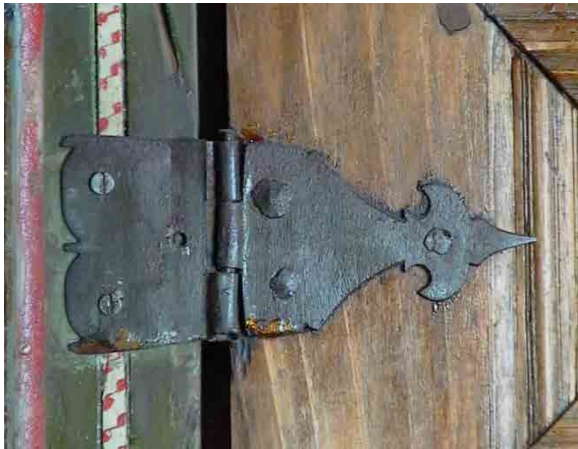
Abb. 436: Aleppo-Zimmer Berlin, linke Wandschranktür der Wand I (Zinnfolie nicht erkennbar in dieser Abbildung; die Reste der Zinnfolie sind nur wenige Millimeter groß, befinden sich an der Unterkante des Scharniers unter den gelben Harzansammlungen und wurden zweifelsfrei mittels SEM-EDS identifiziert)
