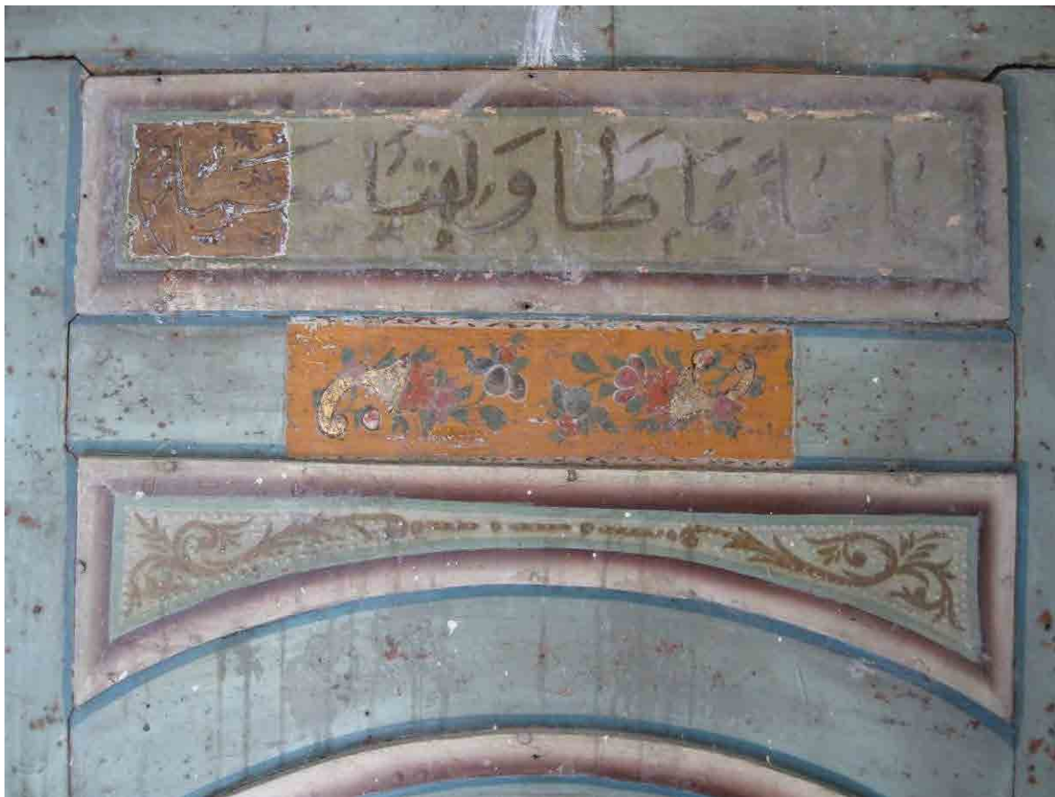
Abb. 591: Bait an-Nawfara, Damaskus, Tests zur Abnahme späterer Übermalungen, ausgeführt von Shadi Khalil, Juni 2010
