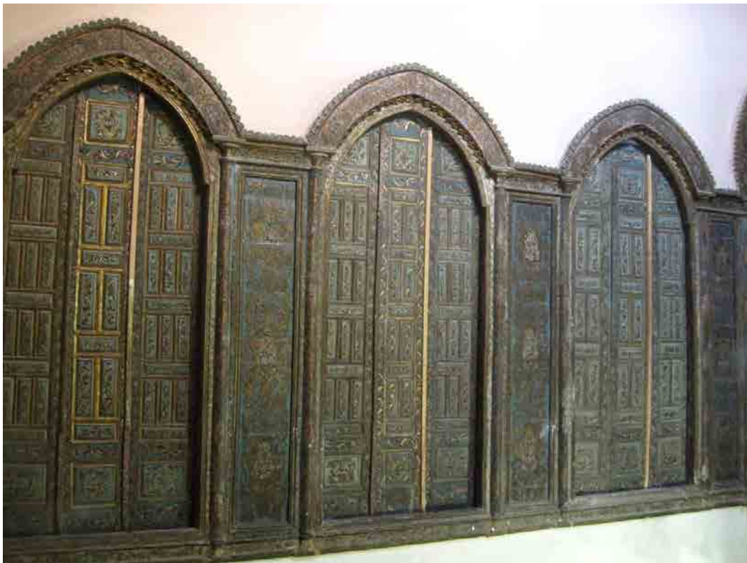
Abb. 426: Bait Muḡallid, Kat.-Nr. IX-252, Raum östlich des īwān , Westwand mit geschlossenen Fensterläden, von denen der jeweils linke aus zwei Flügeln besteht, die mittels Scharnier nach hinten gefaltet werden
