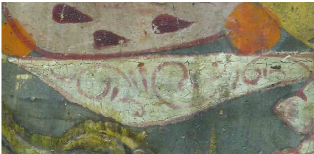
Abb. 449: Dresdner Damaskuszimmer, Detail einer mit weißer Farbe gemalten Porzellanschale, entlang der Kanten haben sich feine Krakeleerisse gebildet
