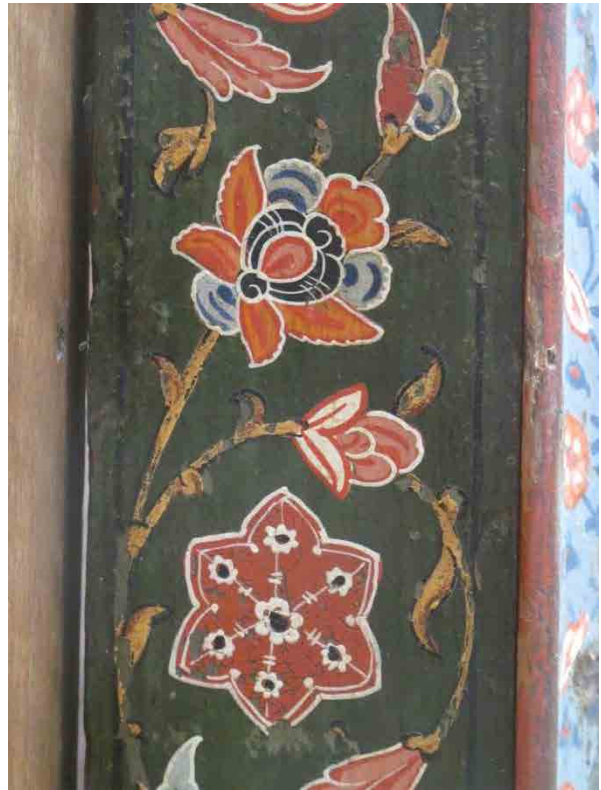
Abb. 404: Typ B1 – dünne, farblose, transparente Lackschicht über zweischichtigem Rot (Mennige und dünne Zinnoberschicht), Querschliffe gleichen Aufbau siehe A 03, A 04, A 08, A 09, A 10, A 11, A 20 im Anhang
