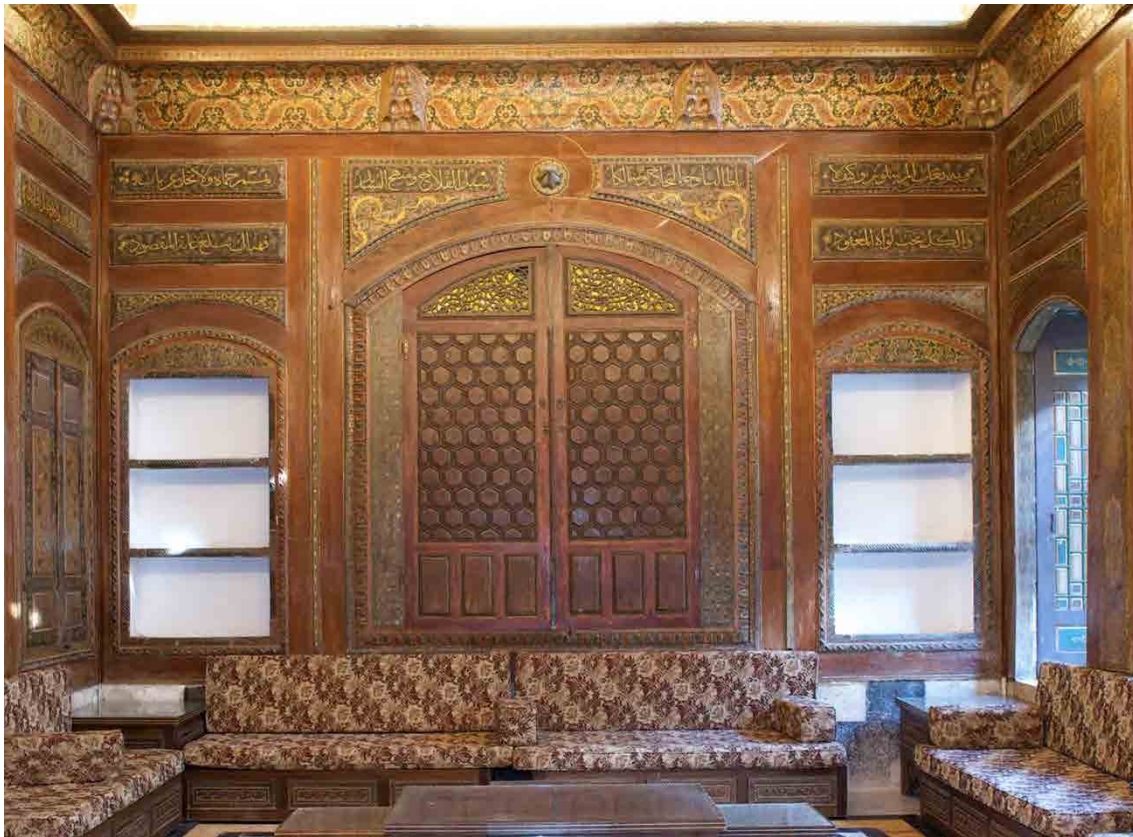
Abb. 525: Bait as-Sibā'ī, Kat.-Nr. XIII-227, später eingesetzte Tür in die ursprünglich offene Nische, der Rahmen der Nische ist geschnitzt und lässt daher das Anbringen von Scharnieren nicht zu, deshalb wurden Wandpaneele aus anderen Zimmern verwendet, gekürzt und eingebaut
