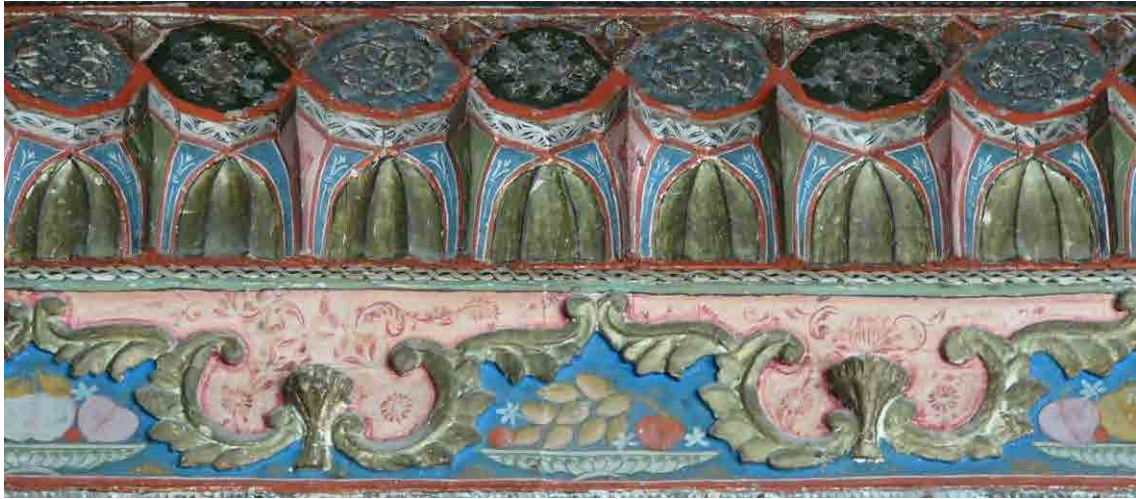
Abb. 554: Bait al-Ḥawrānīya, Kat.-Nr. XXI 2-961, Raum östlich des īwān im inneren Hof, datiert 1204 H / 1789-90 AD, vollständig vergrünte Schlagmetallauflagen auf den Schnitzereien
