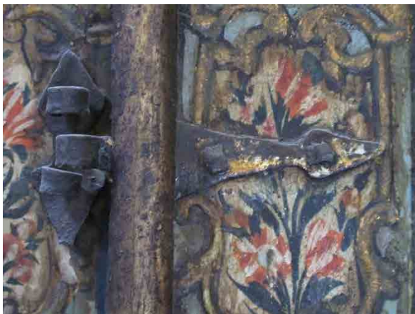
Abb. 438: Bait Muğallid, Kat.-Nr. IX-252, Raum westlich des īwān , rechte Wandschranktür der Westwand, Schließe einer Wandschranktür mit Resten einer Zinnfolienauflage und gelbem Lack
