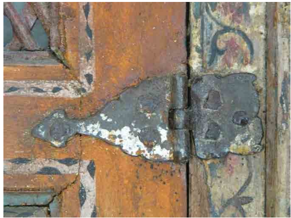
Abb. 436: Aleppo-Zimmer Berlin, linke Wandschranktür der Wand I (Zinnfolie nicht erkennbar in dieser Abbildung; die Reste der Zinnfolie sind nur wenige Millimeter groß, befinden sich an der Unterkante des Scharniers unter den gelben Harzansammlungen und wurden zweifelsfrei mittels SEM-EDS identifiziert)
