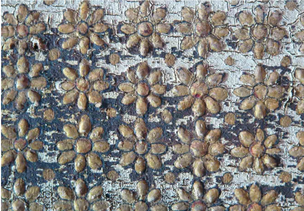
Abb. 345: Qaşr al-‘Azm Hama, NO-Raum im OG des nördlichen Hofes, Paneelrahmen mit regelmäßigem Blümchenmuster oberhalb der Fenster in der Nordwand, komplett vergoldete Oberfläche, der Hintergrund mit transparenter, dunkelroter, heute verbräunter Farbe bemalt
