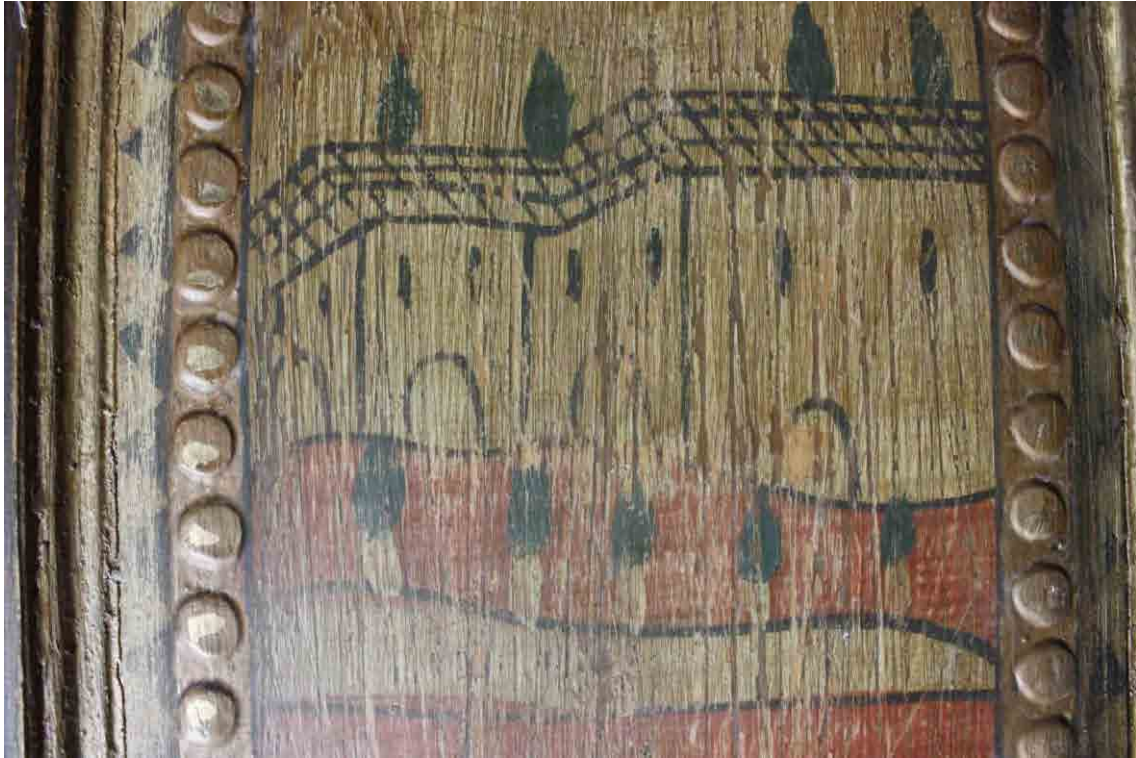
Abb. 609: Bait Farhī / al-Mu'allim, Damaskus, Kat.-Nr. XI-277, westlicher barrānī , Raum westlich des īwān , durch Abschleifen mit Sandpapier zerkratzte Oberfläche
