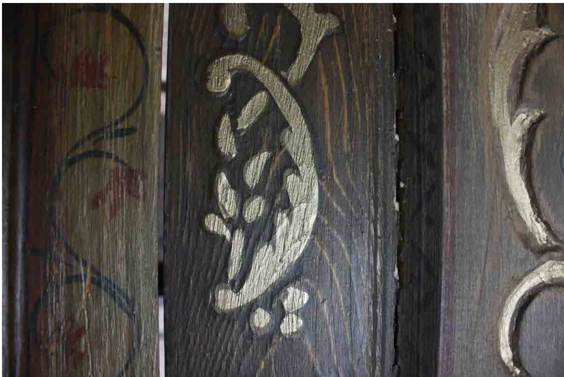
Abb. 610: Bait Farhī / al-Mu'allim, Damaskus, Kat.-Nr. XI-277, westlicher barrānī , Raum westlich des īwān , durch Abschleifen mit Sandpapier zerkratzte Oberfläche
